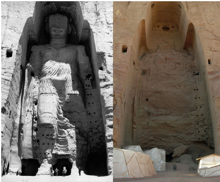
Posąg Buddy w Bamina przed i po zniszczeniu. Fot. Wikipedia
