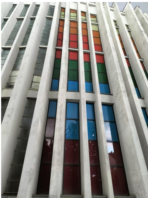
Fragment elewacji kościoła pw. Świętego Krzyża. Fot. NID Szczecin, 2025
