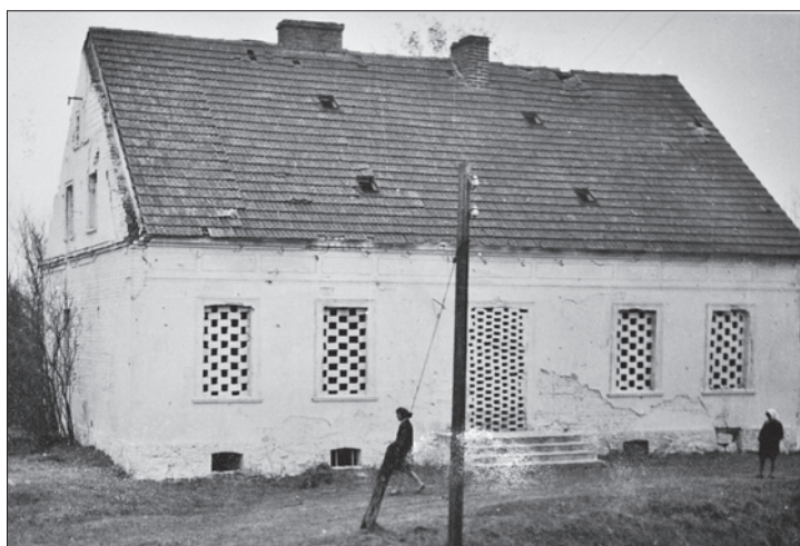
Opuszczony i częściowo zrujnowany budynek w Gozdowicach, w którym w 1965 roku otwarto Muzeum Pamiątek Wojsk Inżynieryjnych 1. Armii Wojska Polskiego, przed 1964 r. Fot. autor nieznan, zdjęcie z albumu „Ob[ywatelowi] Wiceministrowi Obrony Narodowej...”, ze zbiorów Muzeum Wojsk Inżynieryjnych i Chemicznych we Wrocławiu (oddział Muzeum Wojsk Lądowych w Bydgoszczy), nr inw. 2116/51, reprodukcja P. Maliński
