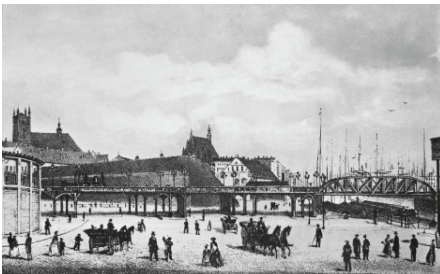
Ryc. 5. Robert Geissler, Widok wiaduktu i mostu nowej linii kolejowej do Poznania, 1869, litografia, Muzeum Narodowe w Szczecinie
