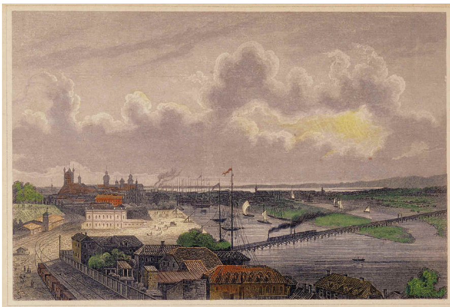
2. Autor anonimowy, Widok od południa stacji i mostu palowego na trasie do Stargardu, 1850, staloryt, Muzeum Narodowe w Szczecinie
