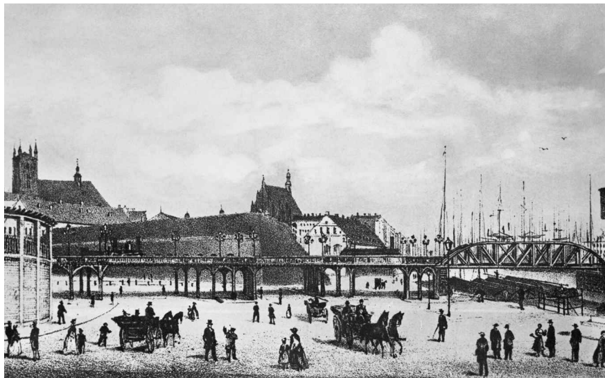
5. Robert Geissler, Widok wiaduktu i mostu nowej linii kolejowej do Poznania, 1869, litografia, Muzeum Narodowe w Szczecinie
