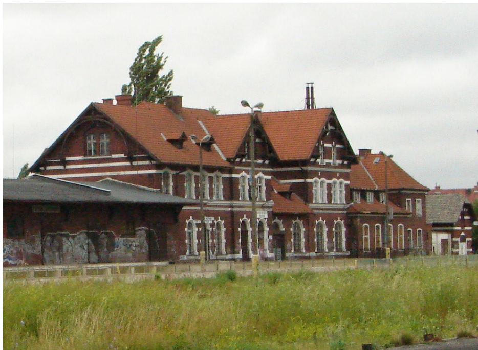
Dworzec kolejowy w Wałczu
